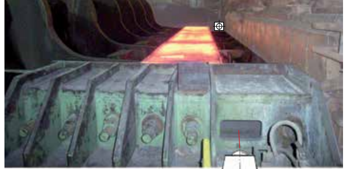
Längenmessung vor dem Hubbalkenofen
